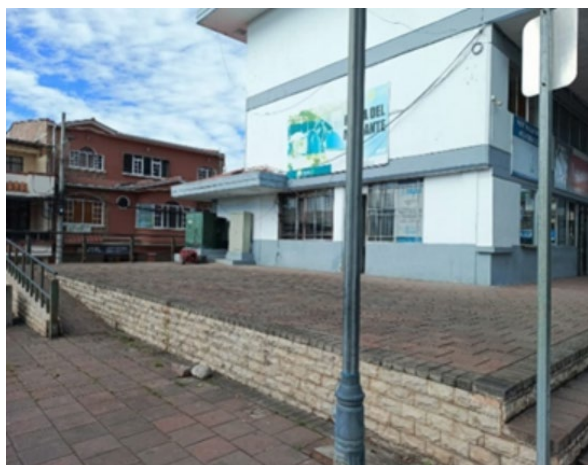
Ilustración 6 Rampa de acceso para personas con discapacidad
